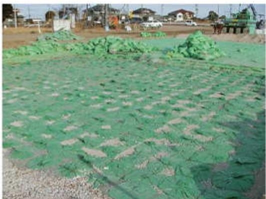
写真6 D・BOX-SS45の敷設状況
