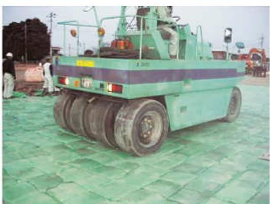
写真7 タイヤローラーで転圧中の角土のうの最上面
