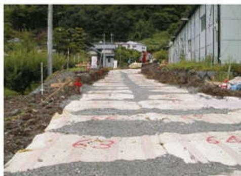
写真12 D・BOX工法(LS150)の施工状況
