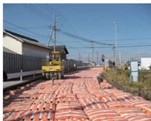
写真17 D・BOX敷設後の転圧状況
