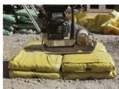
写真10 ジョイントで連結されたD・BOX-SS45
