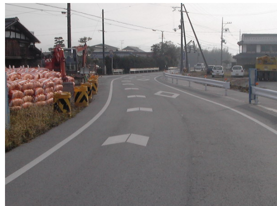
図-15 施工前の道路状況
