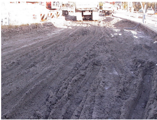
図-16 施工前の地盤状況
