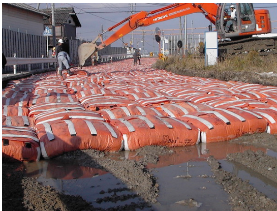
図-17 D・BOXの敷設状況
