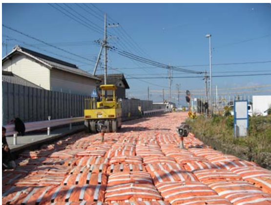
図-18 D・BOX敷設後の転圧状況
