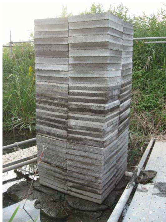
図-9 沼地（深さ約2mのヘドロ層）載荷試験でのD・BOX上のコンクリート平板の積層状態（80cm×80cm×高さ約1.9m）
