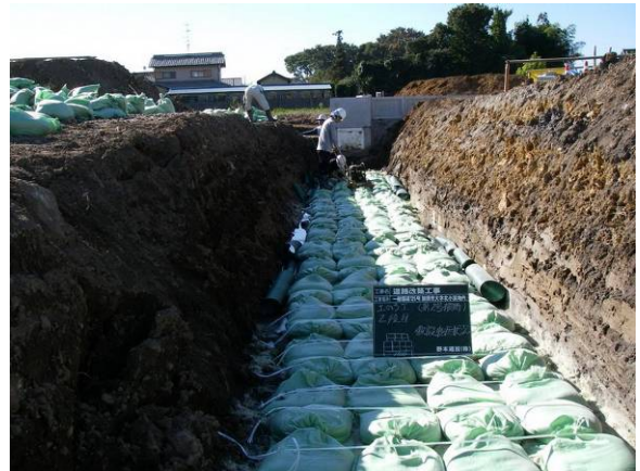
写真-2 道路を横断する農業用水路（ボックスカルバート）下の土のうによる地盤補強
