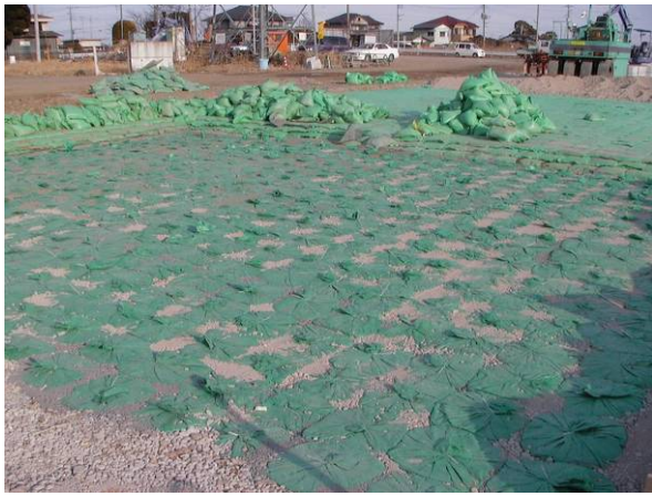
写真-6 中詰め材を投入・転圧後のガイドゲージ付き高規格連結土のうの状況
