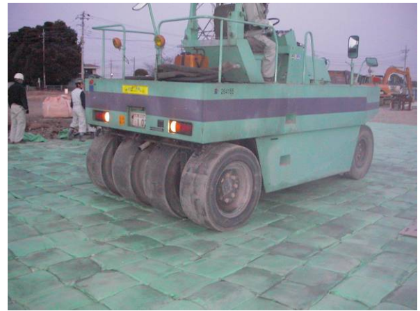
写真-7 12 t f (約 120kN) タイヤローラーで転圧中の角土のうの最上面
