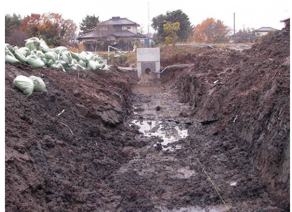
写真-1 道路を横断する農業用水路のための掘削
