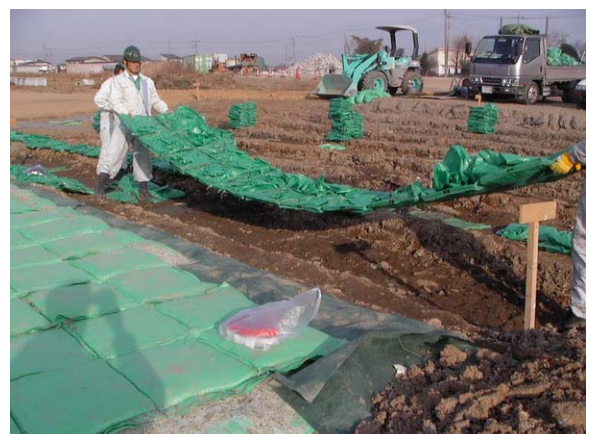
写真-5 ガイドゲージ付き高規格連結土のうの作業状況
