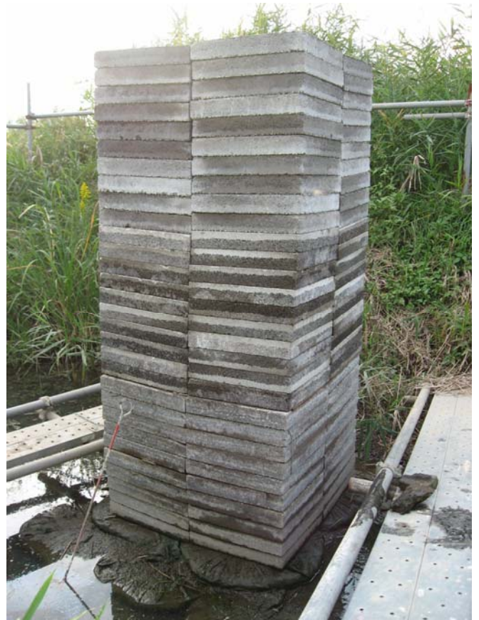
写真-8 沼地載荷試験での土のう上のコンクリート平板の積層状態 (80cm×80cm×高さ約 1.9m)
