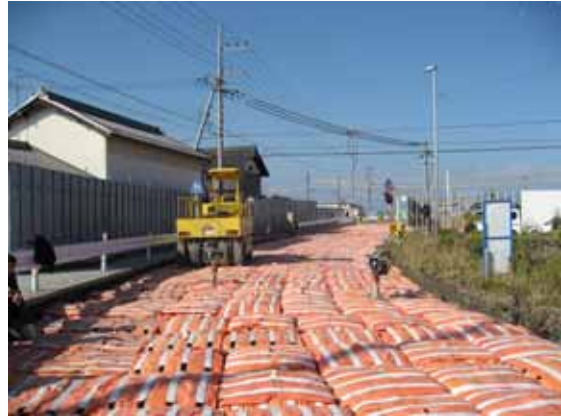
写真-17 D・BOX敷設後の転圧状況
