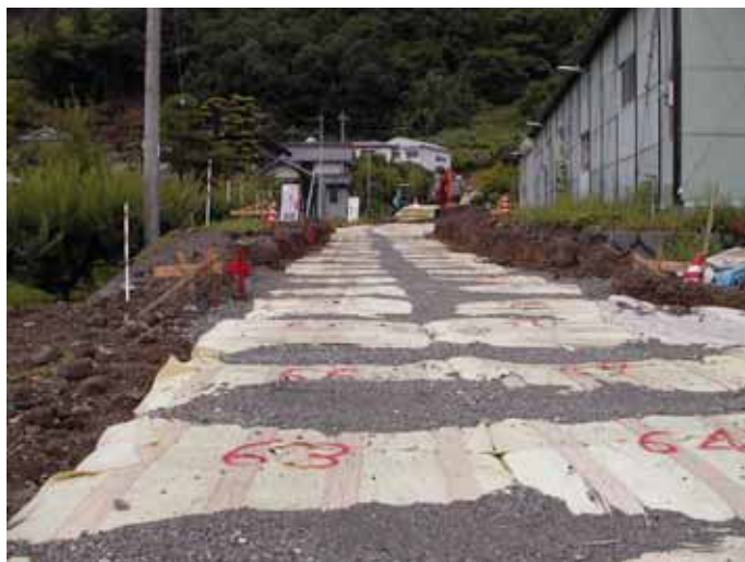
写真-12 D・BOX 工法 (LS150) の施工状況
