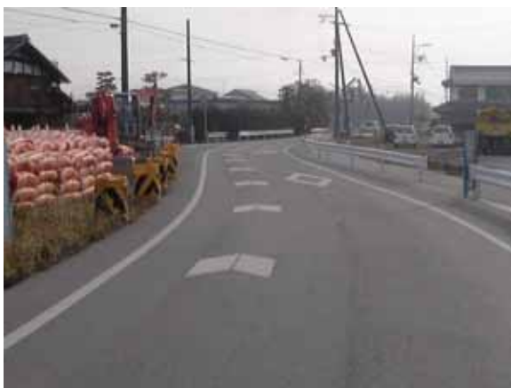
写真-14 施工前の道路状況
