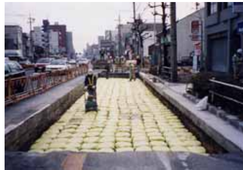
写真-3 名古屋市赤塚交差点付近での土のう積層体を用いた防振工の施工状況
