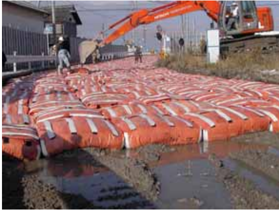
写真-16 D・BOXの敷設状況
