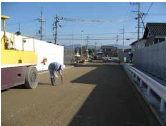
写真-18 上層路盤の施工状況
