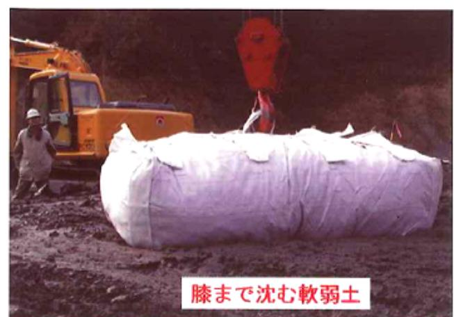
口絵写真—8 膝まで沈む軟弱土上にほとんど沈下することなく設置される大型土のう
