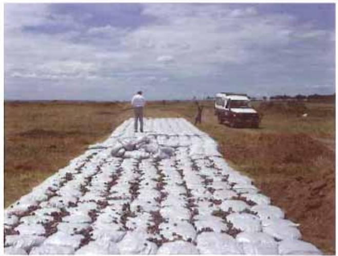
口絵写真-9 ケニヤ現地での大型土のうへの中詰め材の投入状況(重機による吊り上げを必要としない施工方法を考えた)
