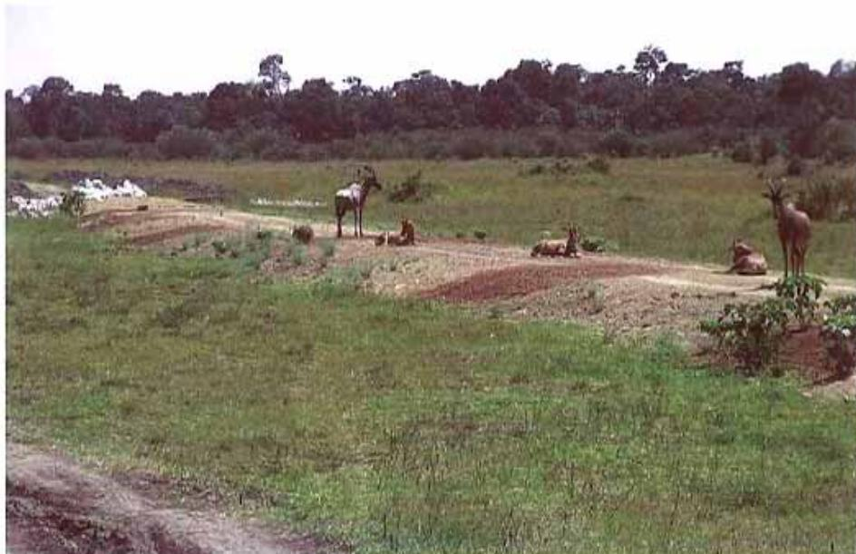
口絵写真-11 土のう3段の上を現地発生路盤材「マラム」で覆って転圧した上のう積み道路上に寝そべる動物たち(トビ)
